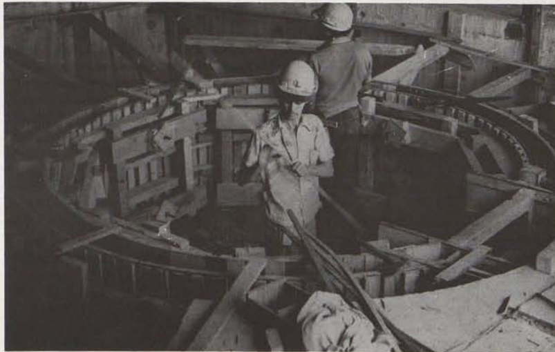
Moldes de concretagem para base da pia batismal
