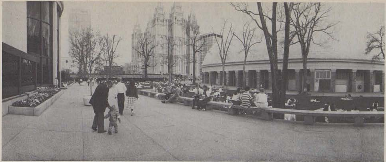
Vista geral da Praça do Templo.
