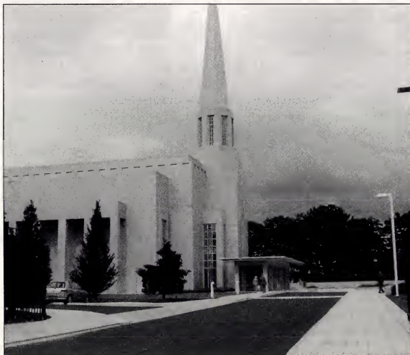
De buitenkant van de Preston-tempel is van Italiaans graniet; dezelfde natuursteen zal worden gebruikt voor de buitenkant van de Den Haag-tempel.
