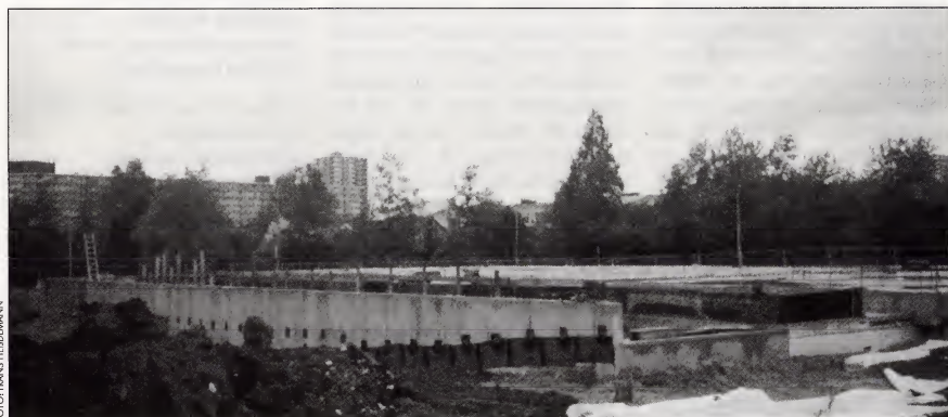
Het plafond van de parkeergarage, resp. de vloer van de begane grond (begin juni). Op de voorgrond is de hellingbaan (inrit van de parkeergarage, aan de achterkant van de tempel) te zien.
