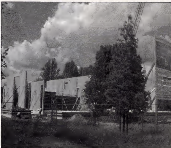
De Den Haag-tempel in aanbouw, rond de tijd dat de buitenmuren werden geplaatst.
