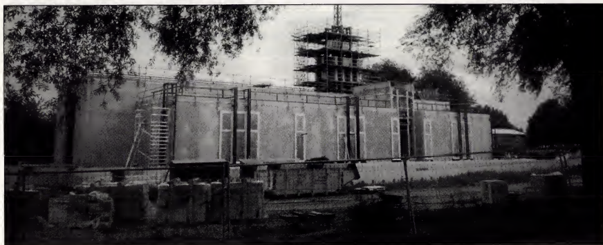
Het bouwterrein van de tempel in Zoetermeer, van achteren gezien.
