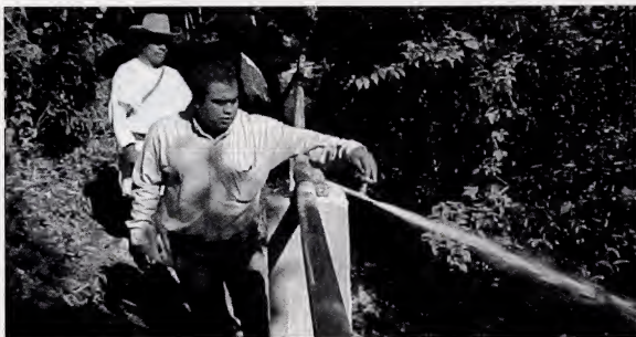
De waterdruk in een waterpijp in Chojoló (Mexico), die rust op met de hand gemaakte cementen pylonen, wordt getest.
