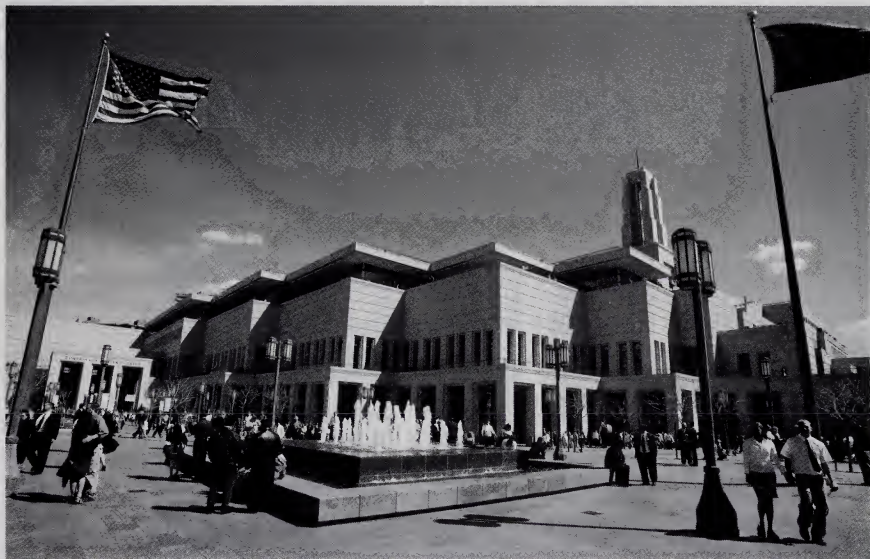
Een groothoekbeeld toont het Conferentiecentrum vanaf de zuidwestelijke hoek van het buitenplein.
