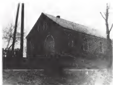
Het gebouw van de RING Hamburg.
