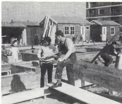
Broeder Muntinga, de opzichter van dit bouwproject, geeft aan een van de plaatselijke leden aanwijzingen wat er gedaan moet worden.
