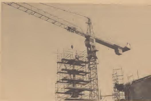
Het beeld wordt op de torenspits geplaatst.
