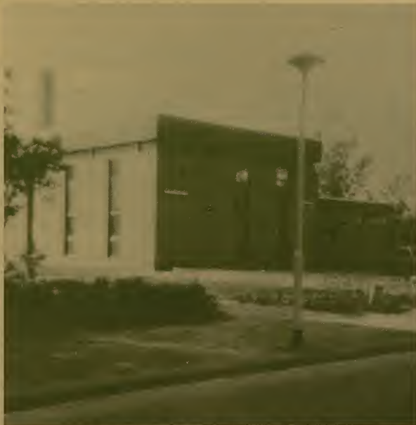
De nieuwe vleugel aan het gebouw van de Wijk Groningen
