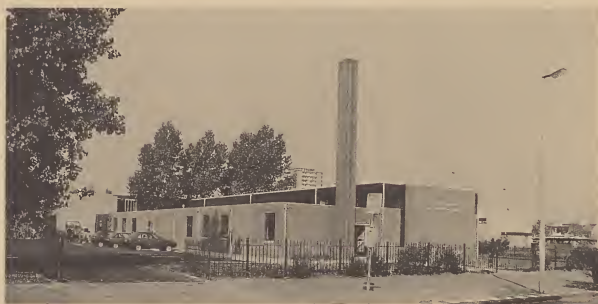
De nieuwe vleugel van de achterzijde gezien.
