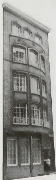
Het zendingskantoor aan de Appelmansstraat in Antwerpen.
