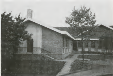
Achterkant van het gebouw.
