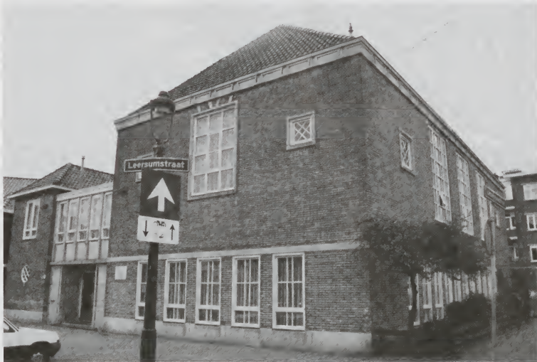
Het huidige kerkgebouw aan de Leersumstraat.
