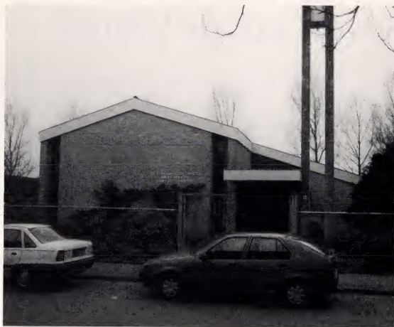
Het kerkgebouw in Arnhem.
