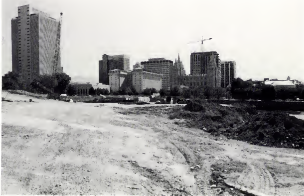
De uitgraving is in volle gang voor het nieuwe vergadercentrum met een capaciteit van 21000 zitplaatsen, het bouwterrein ligt aan de noordkant van Temple Square. Het gebouw, dat tijdens de aprilconferentie in 1996 door president Gordon B. Hinckley werd aangekondigd, zal vanaf 2000 de conferentiebijeenkomsten behuizen. In het midden van de foto zijn de torens van de Salt Lake-tempel te zien en het kantoorgebouw van de kerk helemaal links.
