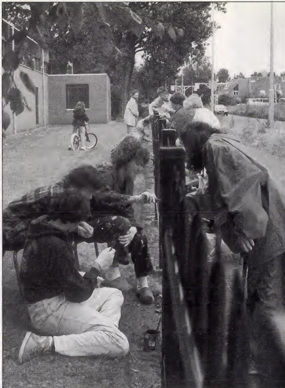
Werken aan het lange hek: vele handen maken licht werk.
